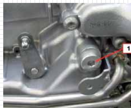
1 Desbordamiento de aceite (hidráulico)
