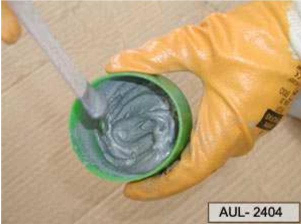
Mezclar la cantidad suficiente de la [masilla de aluminio Diamant de 2 componentes](#) . Debe conseguirse una consistencia adecuada para el enmasillado
